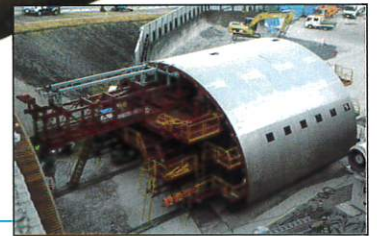
セントル (覆工コンクリートをつくるための型わく)
