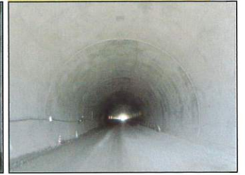
⑦ 覆工コンクリート
