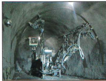
コンクリート吹き付け機 (支保工も建て込める機械)
